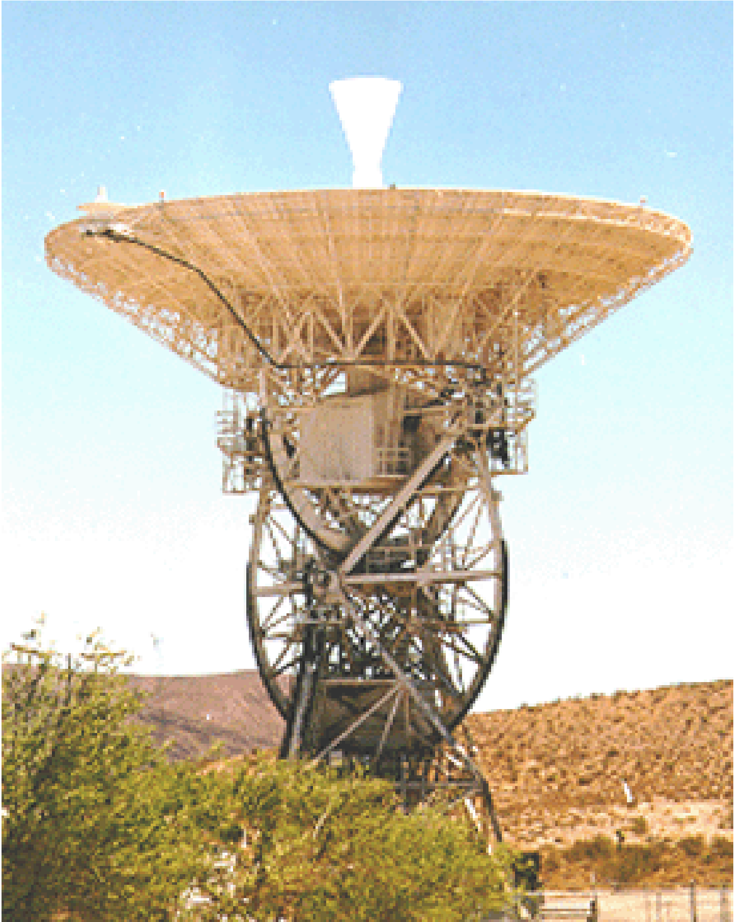
هذه صورة للهوائي DSS16 وهو تلسكوب راديوي يبلغ قطره حوالي 26-m. لعلك تستطيع ملاحظة الموجد أعلى الحافة، على الجانب الأيسر من الطبق. المصدر: Dave Doody
