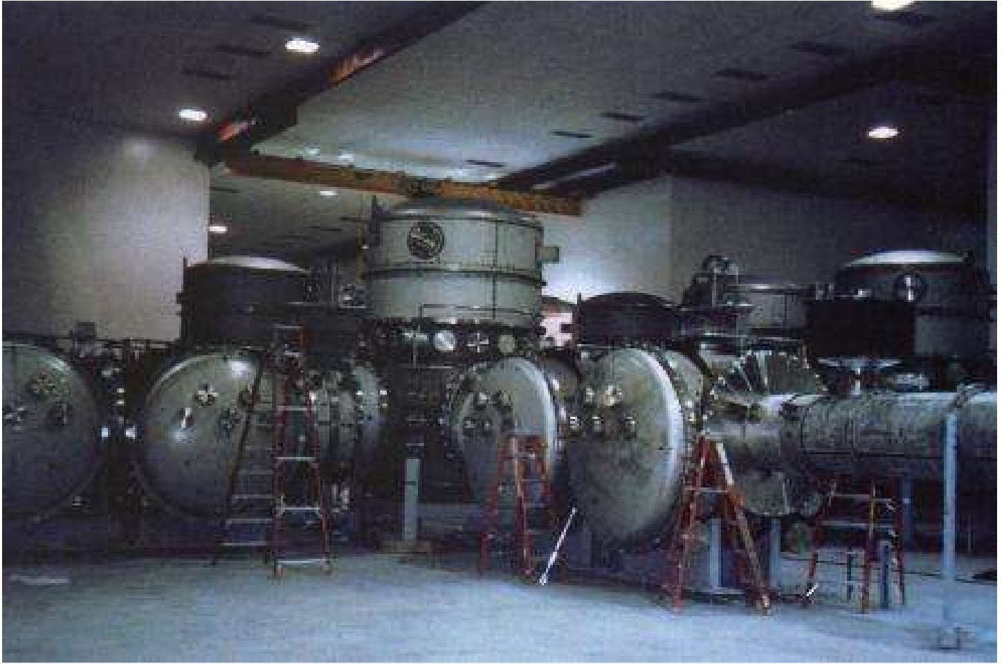
بحلول فبراير/شباط لعام 1998، رُكبت معدات التفريغ على شكل حرف L، ويأوي الخزان المركزي العمودي على مقسم الأشعة. يمتد الجانب الأيمن لأنابيب الأشعة نحو الصحراء، حقوق الصورة: LIGO. Credit: LIGO.
