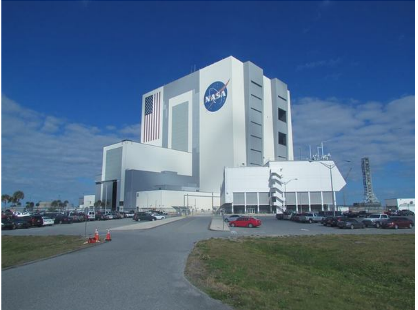
مبنى تجميع المركبات، أضخم مبنى من طابق واحد في العالم وأعلى مبنى في الولايات المتحدة الأمريكية خارج المناطق الحضرية
