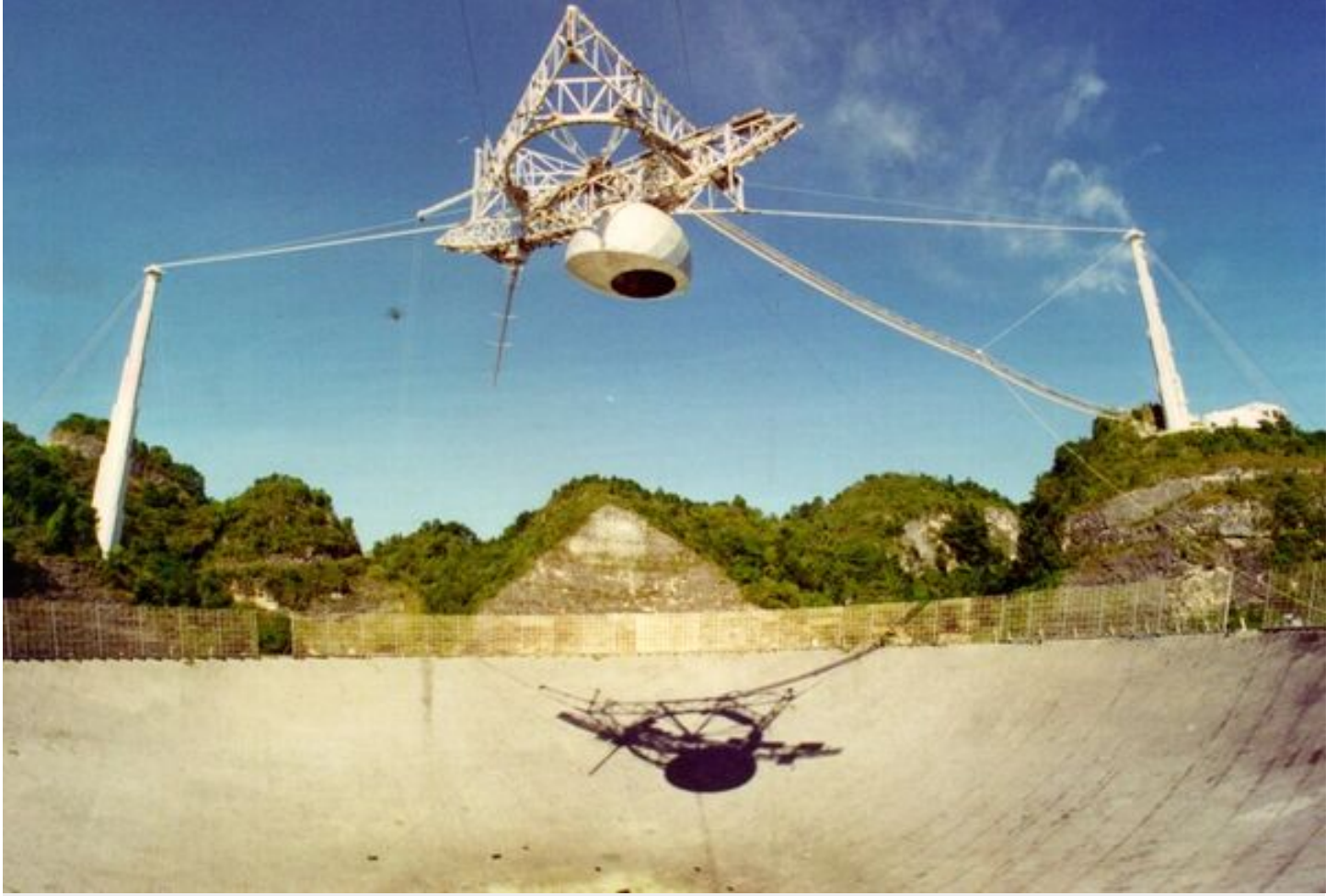
تُظهر هذه الصورة الأرشيفية للطبق الراديوي الضخم في مرصد أريسيبو المنصة العلمية الثقيلة المعلقة فوقه، واثنان من الأبراج الداعمة والكابلات الداعمة لها. حقوق الصورة: Courtesy of the NAIC – Arecibo Observatory, a facility of the NSF
