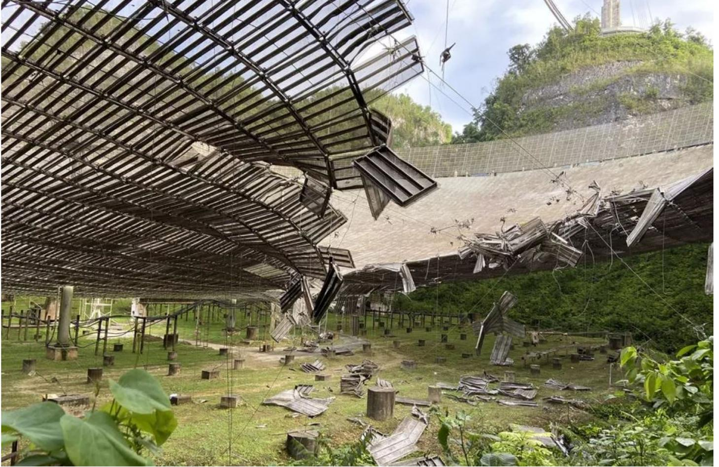
صورة لتلسكوب مرصد أريسيبو الراديوي المتميز كما يبدو بعد انهيار اثنين من الكابلات الحاملة، والذي سبق انهيار المنشأة. حقوق الصورة: University of Central Florida
